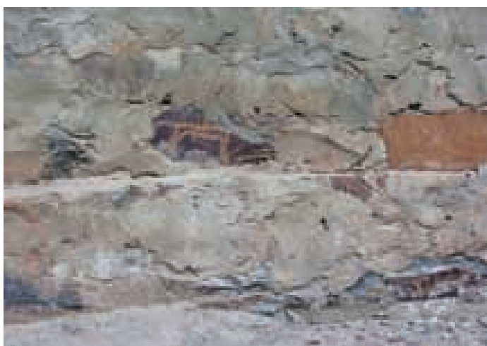
III. 09. Fragments de gravure inclus dans le mur d'un dépôt en bordure de route, le bâtiment porte la date de 1995 inscrite dans le ciment du linteau (L / SRB).
